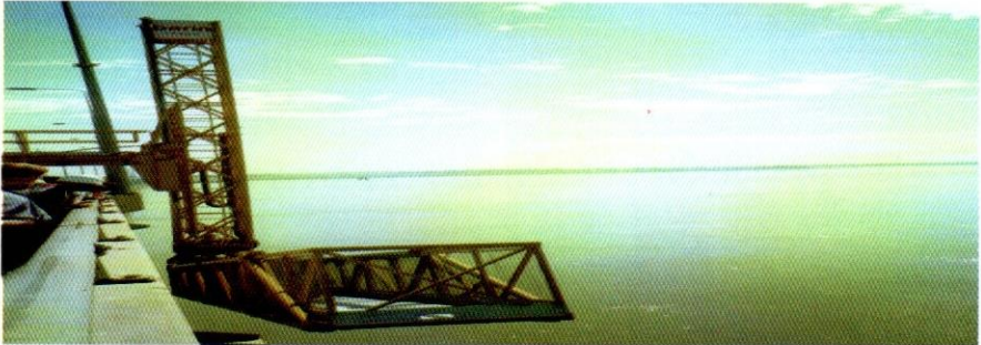
Barin এর মাধ্যমে বঙ্গবন্ধু সেতুর soffit এর inspection এবং maintenance কার্যক্রম
