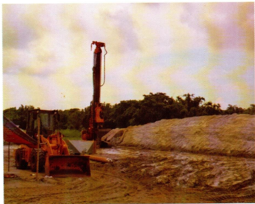
সংযোগ সড়কের sand blasting কাজ
